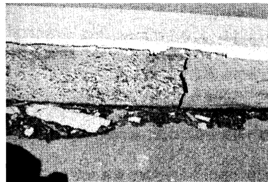
写真-11 砂田橋スケーリングと剥離
