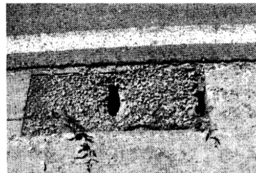
写真-12 砂田橋豆板化
