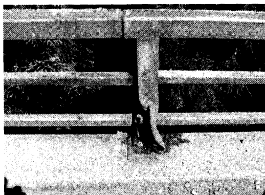
写真-3 子鍋橋高欄部発錆
