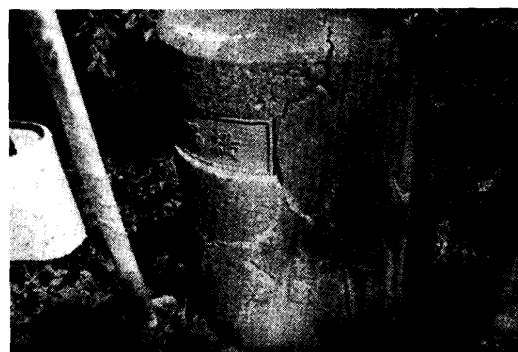
写真-4 子鍋橋アルカリ骨材反応
