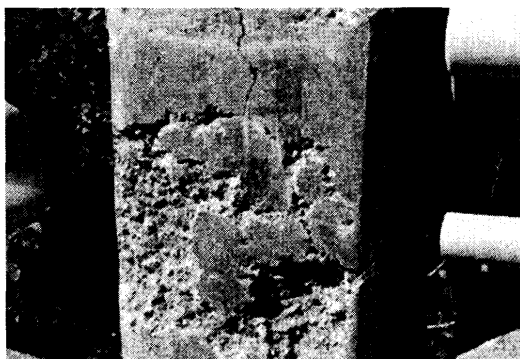
写真-8 戸隠橋アルカリ骨材反応と剥離
