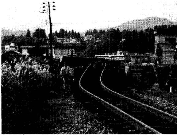
写真 - 19 飯山線魚野川橋梁上部
