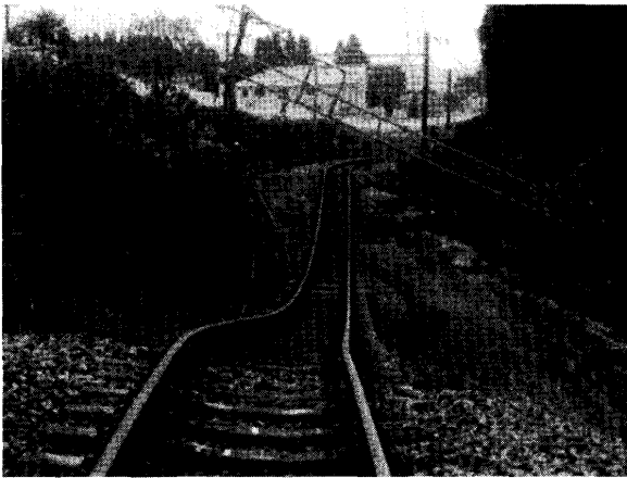
写真 - 25 上越線崩壊
