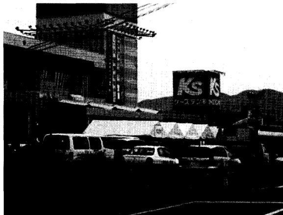
写真-9 スーパーの被害状況
