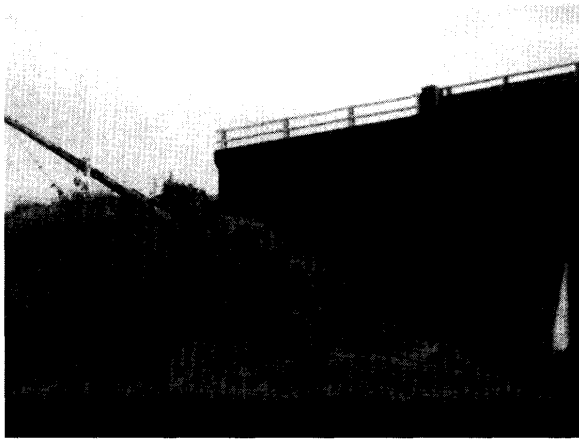
写真 - 31 上越線跨線橋
