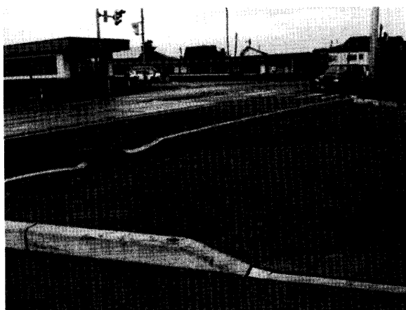
写真 - 3 路面のクラック
