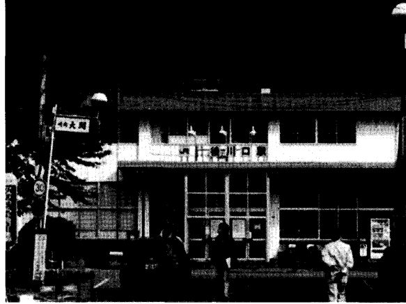
写真 - 15 越後川口駅正面
