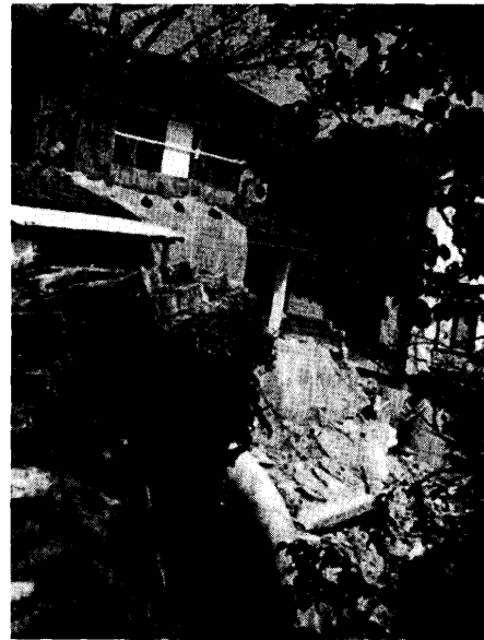
写真 - 24 家屋基礎部からの斜面崩壊
