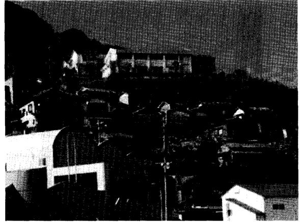
写真 - 15 家屋の被害状況
