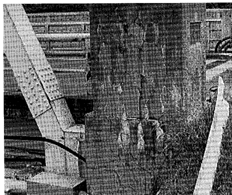
写真-4 小布施橋アルカリ骨材反応
