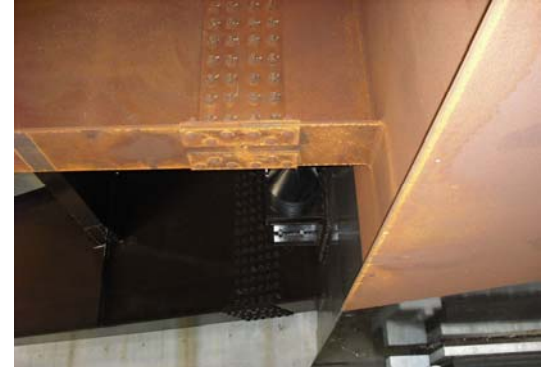
図16 新布施川橋の縦桁
