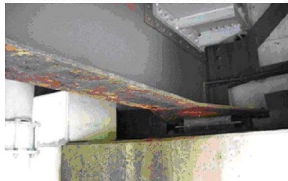
図8 地震滝橋支点近傍
