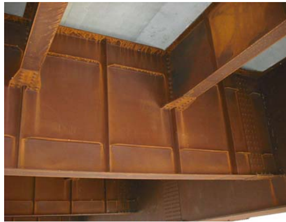
図15 新布施川橋の床桁
