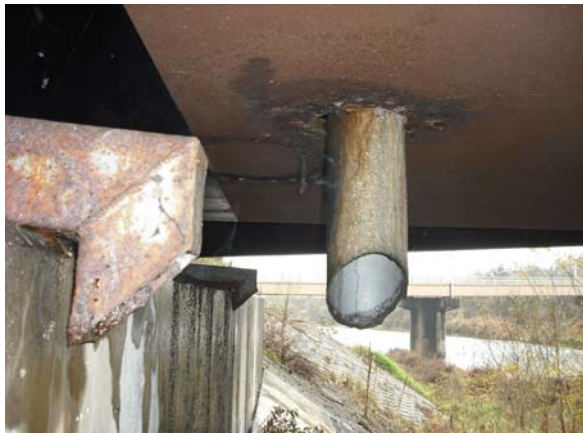
図11 平瀬橋上田市側
