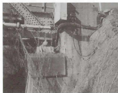
写真 25 橋台損傷
