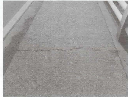
写真2 歩道部ひび割れ
