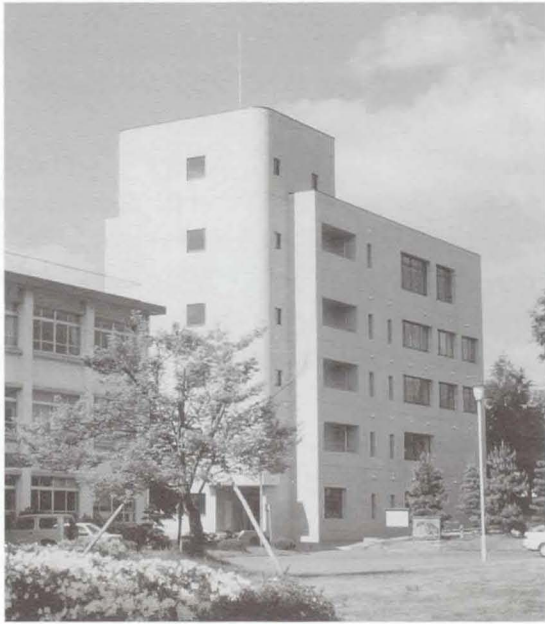
図1 完成直後の電子情報工学科校舎 (1991年5月)
