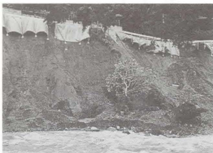
写真3 洗掘による斜面崩壊
