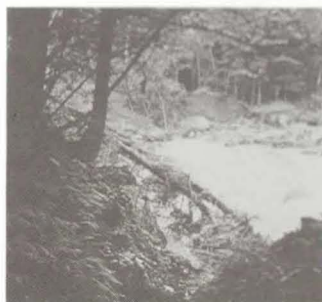
写真4 洗掘による斜面崩壊
