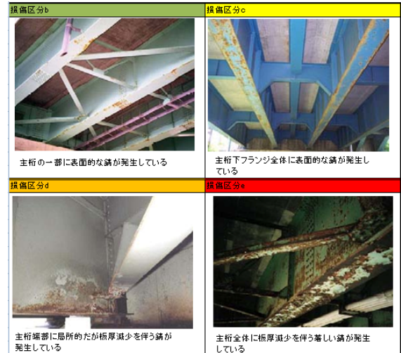
図3 損傷判断基準図（国総研）
