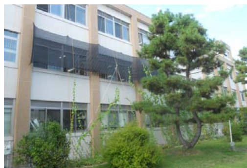
写真4 遮光シート設置状況
