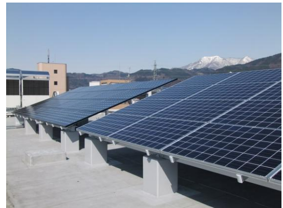
(b) 単結晶シリコン系太陽電池モジュール（左）と多結晶シリコン系太陽電池モジュール（右）
