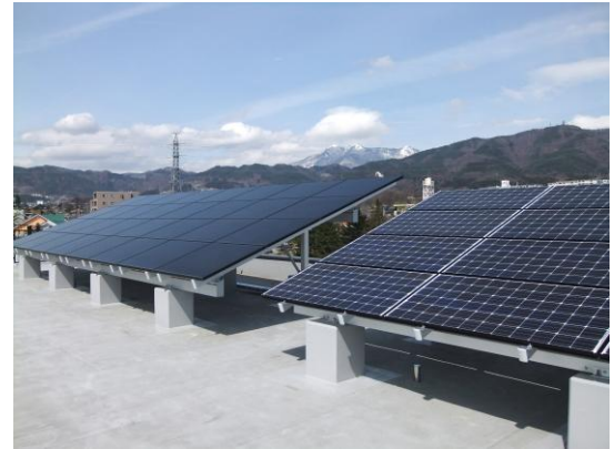
(a) 化合物系薄膜太陽電池モジュール（左）と単結晶ハイブリッド系太陽電池モジュール（右）
